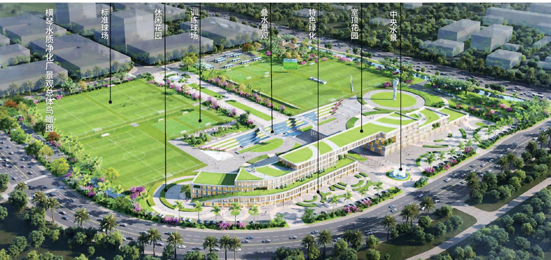
横琴水质净化厂工程建设规模为10万吨/天，远期规模初拟为40万吨/天，设计为全地埋式污水厂。一期工程地下部分设计范围按照土建规模10万吨/天建设（设备按5万吨/天安装），设计出水水质达到地表准四类水标准。该项目由集团以BOT模式进行建设，2020年已完成勘察设计招标、设计方案确认及可行性研究报告初稿等。项目建成后，能够满足横琴新区生活污水处理的需要，并能进一步改善区域的水环境质量，强化综合水污染防治体系，完善原有治污工程建设和运行管理，让横琴岛水更清、景更美。
