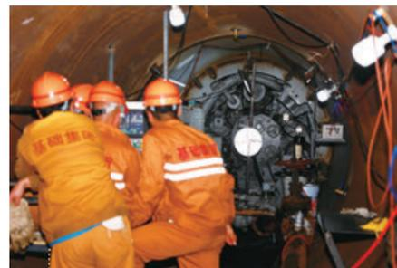
平岗-广昌原水供应保障工程采用顶管机头的施工现场
